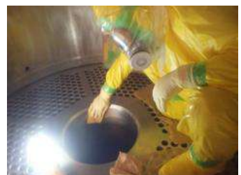
開放点検時系統内除染作業(3)
