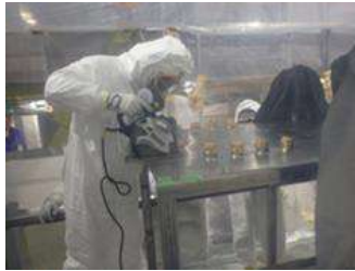
グローブボックス解体撤去作業
