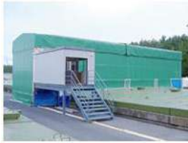
大型防護テント
