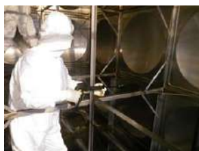
排水設備内の清掃
