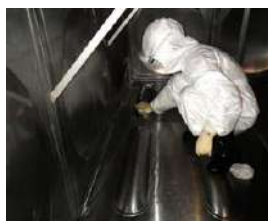
排水設備内の清掃
