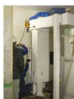
遮蔽体の設計・製作・設置
