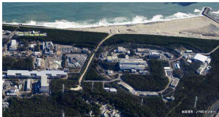
大規模加速器実験施設
