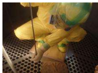
開放点検時系統内除染作業(2)
